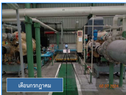
ภาพที่ 3.43 การตรวจวัดระดับเสียงในสถานที่ทำงานบริเวณ Air compressor
